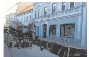
Blick auf die Baustelle in der Kremserstraße Foto: Mag. Elisabeth Stangl
